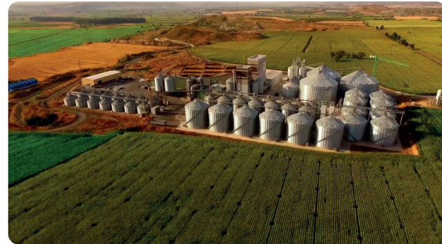
Installation de séchage de maïs en Espagne
